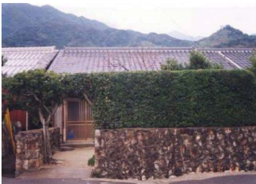
写真99-3 石垣と入口周り
