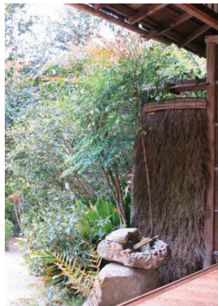
写真92-5 越屋根見上げ
