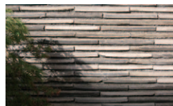
写真84-2 平瓦積み の壁面
