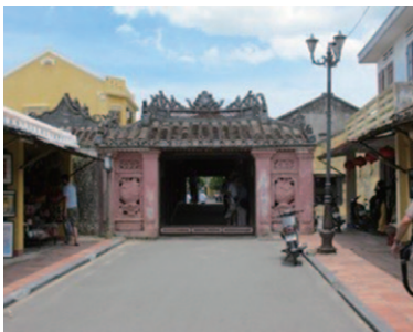
写真78-2 来遠橋 (日本橋)
