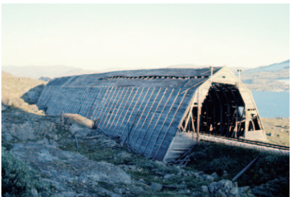
写真47-3 高地鉄路の雪除けトンネル
