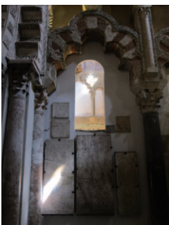
写真46-3 メスキータの教会部分 見上げ
