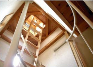
望楼の内部見上げ
