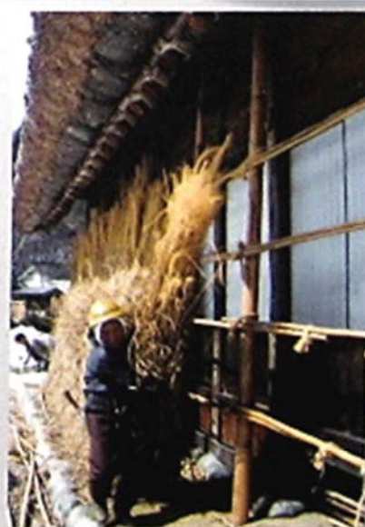
雪囲いの取り付け** Attaching the snow guards
