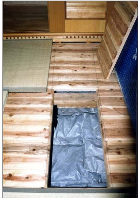
■スギの荒床と床下の廃材木炭
