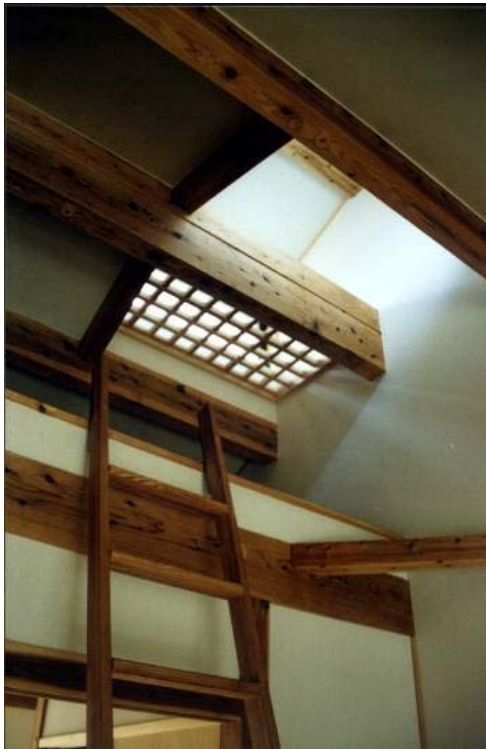
■越屋根の見上げ
