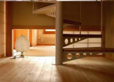
自然換気のための地窓
