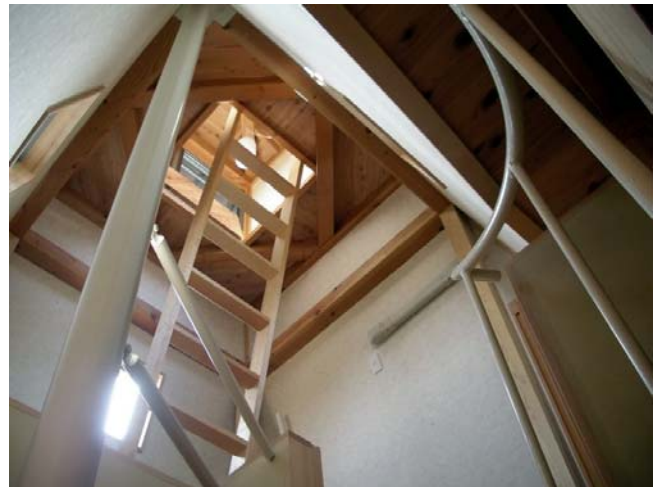
図15 望楼内部見上げ
