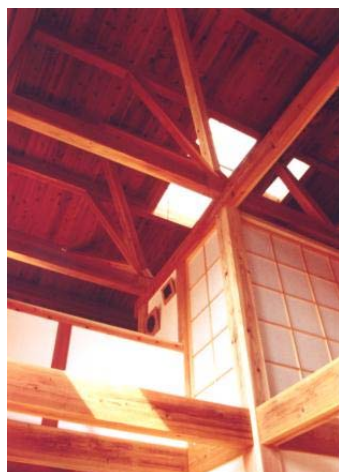
内部光楼見上げ
